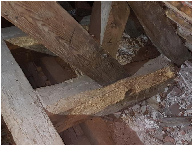
Fot. 39, 40 – Przykłady zniszczeń „kulawek” i krokwi dachowych w części przyokapowej. Konieczna naprawa poprzez wzmocnienia lub wymianę elementów.
