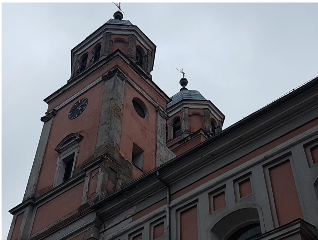
Fot. 16 – Wieża w narożu północno-wschodnim budynku – widok ogólny. Widoczne silne zniszczenia tynków elewacyjnych.
