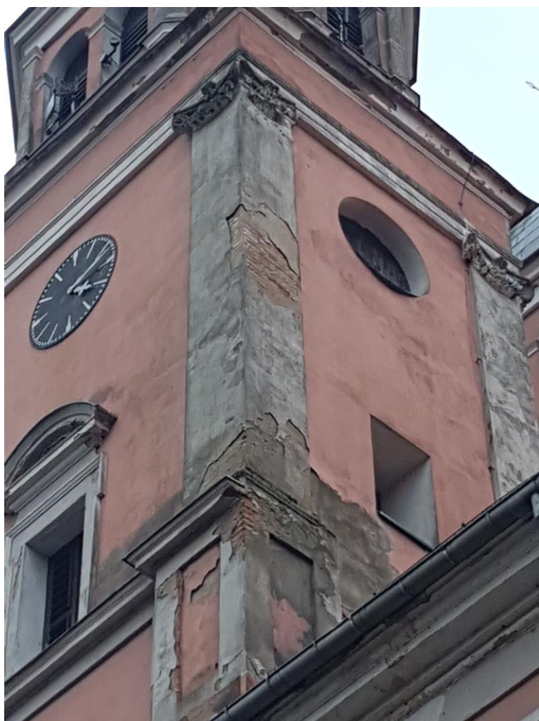
Fot. 16 – Wieża w narożu północno-wschodnim budynku – widok ogólny. Widoczne silne zniszczenia tynków elewacyjnych.
