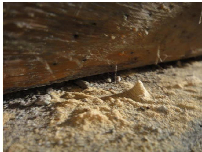
Fot. 42, 43 – Przykładowe ogniska żerowania drewnojadów (owadów szkodników drewna).
