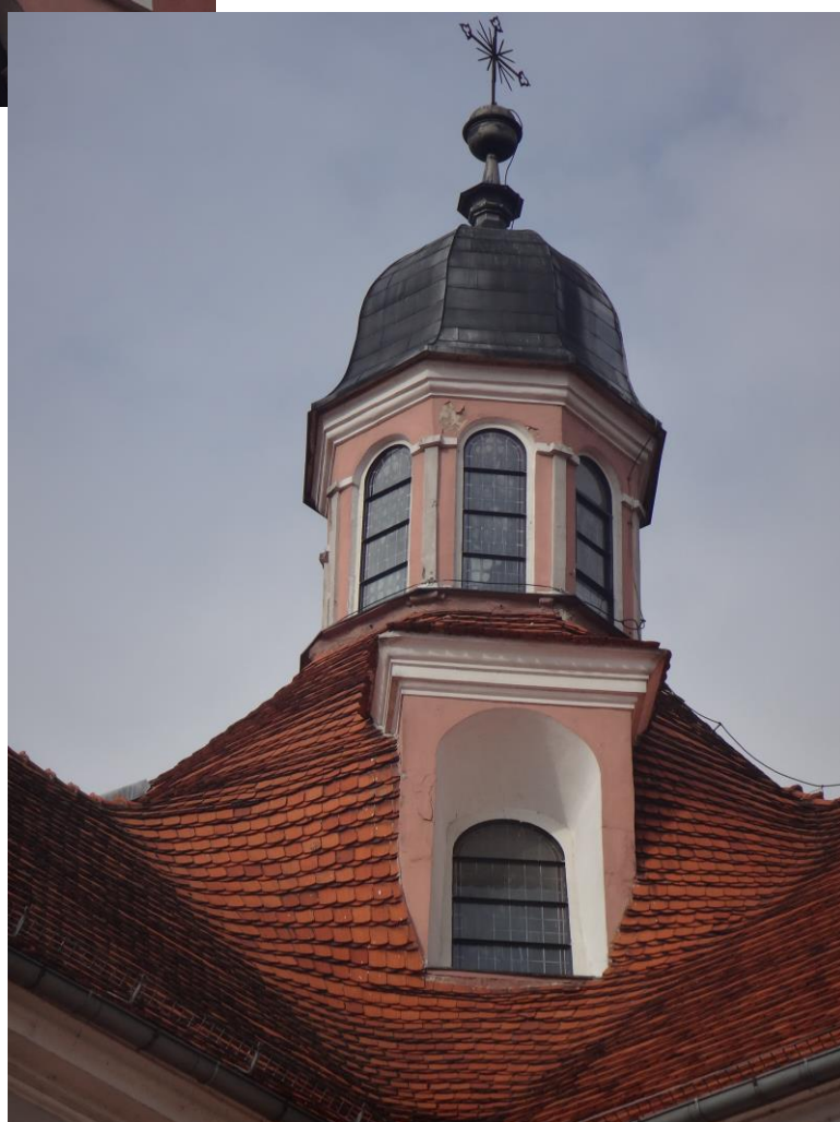
Fot. 22 – Stan zachowania pokrycia na hełmie wieży, wykonanego z blachy tytan-cynk.
