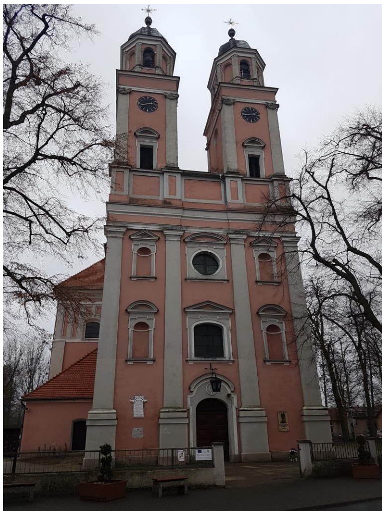
Fot. 1 – Elewacja frontowa (północno-wschodnia) budynku kościoła.
