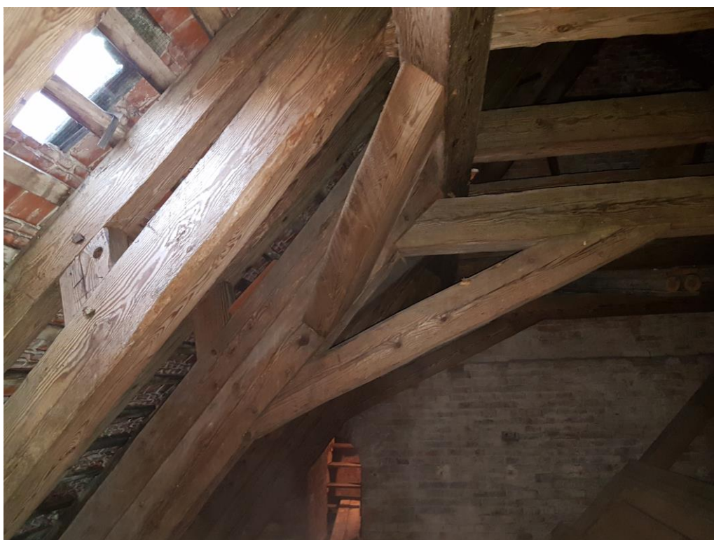
Fot. 33 – Kolejny przykład połączeń elementów więźby dachowej w węzłach (widoczne kotkowanie gwoździami drewnianymi).
