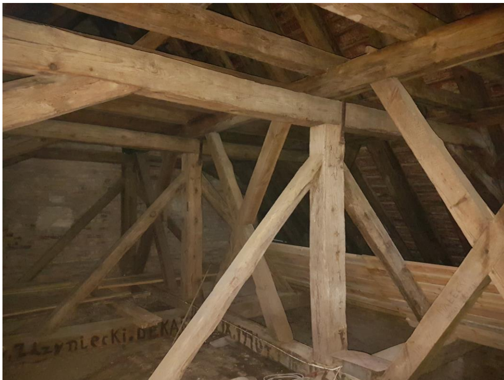
Fot. 25 – Przykład wizualnie zadowolającego stanu technicznego więźby dachowej.
