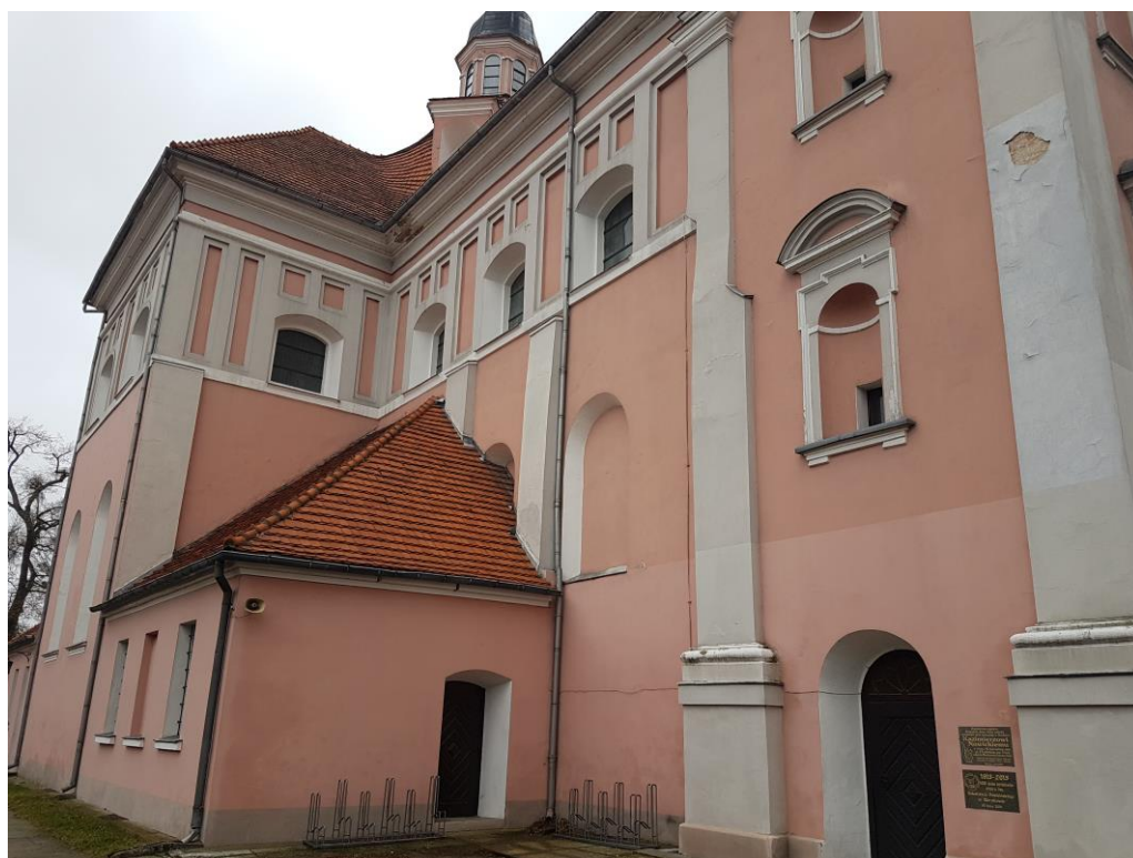
Fot. 2 – Elewacja boczna (południowo-wschodnia) – fragment od strony wschodniej.
