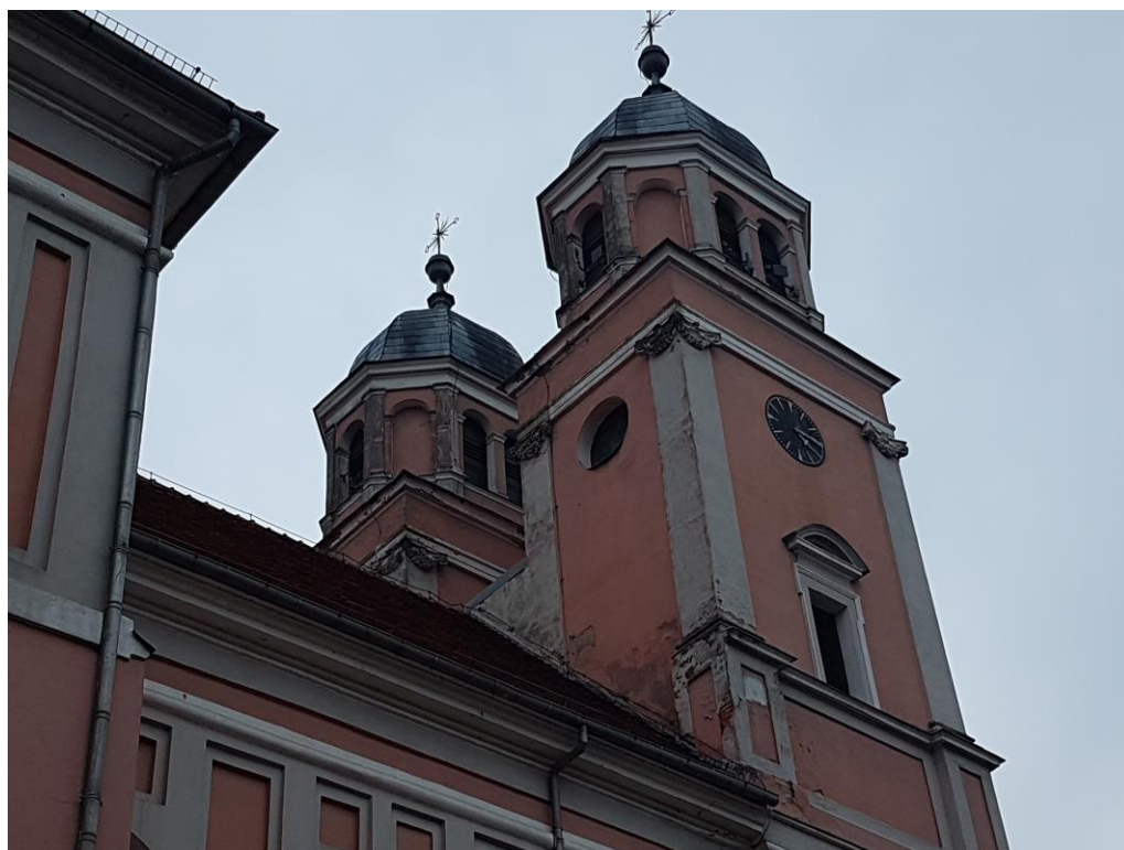
Fot. 6 – Wieże kościoła z hełmami pokrytymi blachą tytan-cynk (widok od strony południowo-zachodniej).
