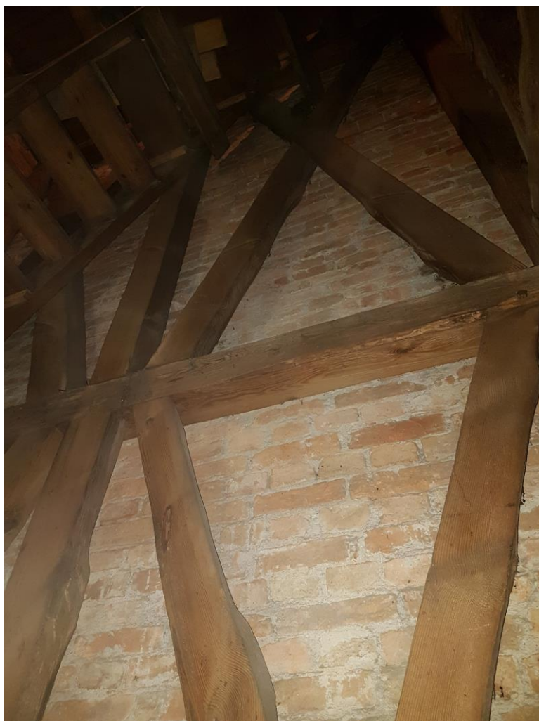
Fot. 45 – Widok ogólny wnętrza wieży. Ściany ceramiczne oraz konstrukcja drewniana w ogólnie zadowalającym stanie technicznym.
