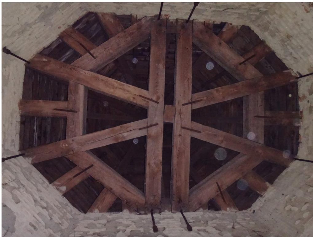
Fot. 48 – Widok ogólny konstrukcji hełmu.
