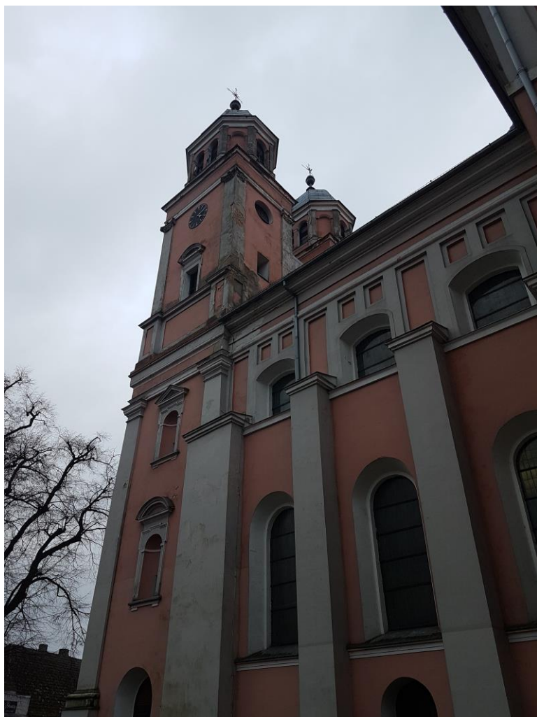
Fot. 5 – Elewacja boczna (północno-zachodnia) – fragment od strony wschodniej (c.d. elewacji bocznej widocznej na fot. 4).
