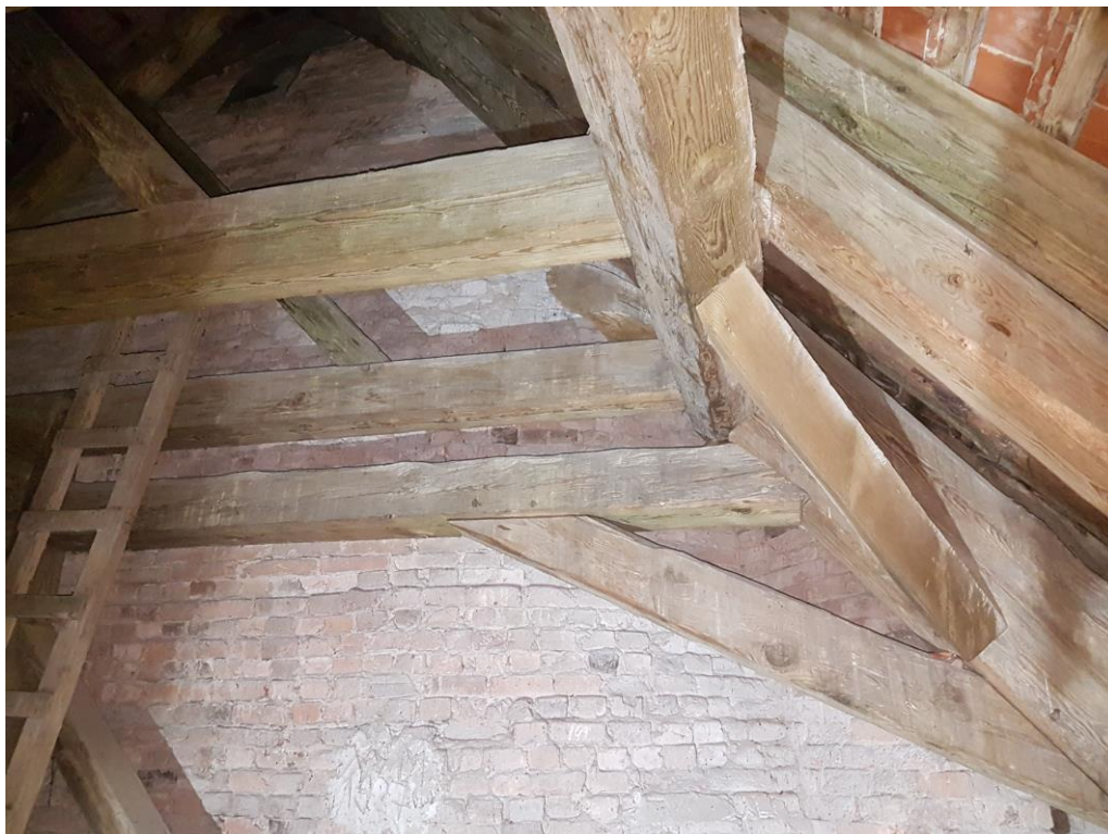
Fot. 32 – Przykład połączeń elementów więźby dachowej.
