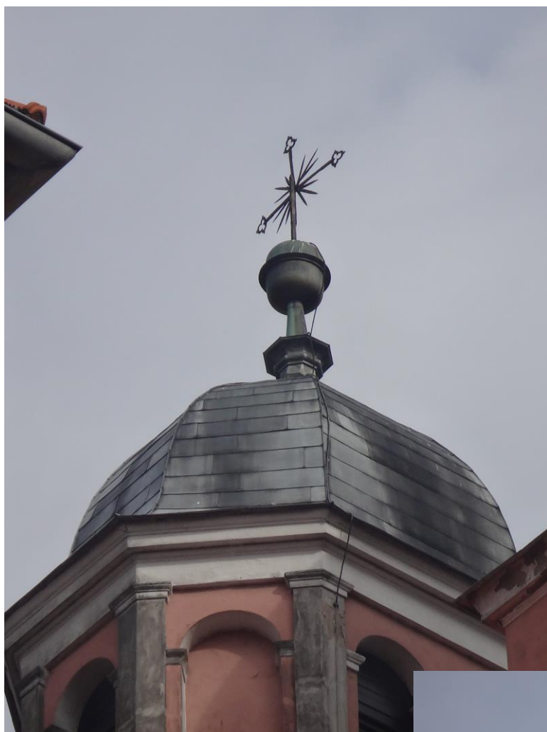
Fot. 22 – Stan zachowania pokrycia na hełmie wieży, wykonanego z blachy tytan-cynk.
