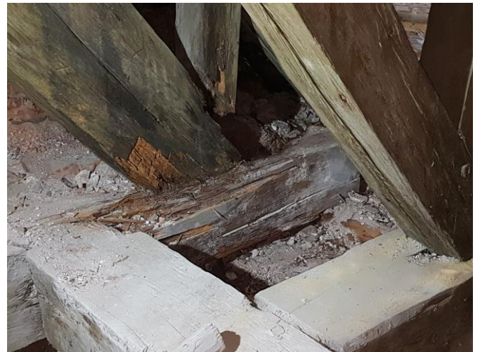
Fot. 39, 40 – Przykłady zniszczeń „kulawek” i krokwi dachowych w części przyokapowej. Konieczna naprawa poprzez wzmocnienia lub wymianę elementów.
